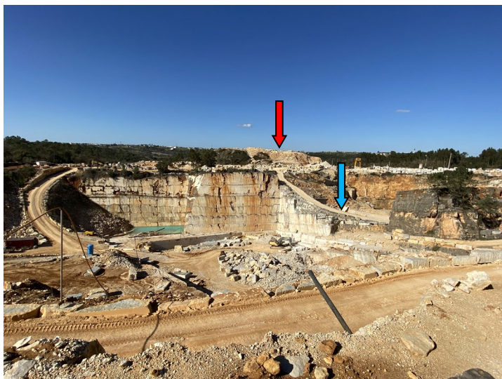
Foto 8 – Vista geral da pedreira, com indicação da rampa que a separa da pedreira vizinha da Farpedra (seta azul). Ao fundo, a escombreira da Farpedra (seta vermelha).
