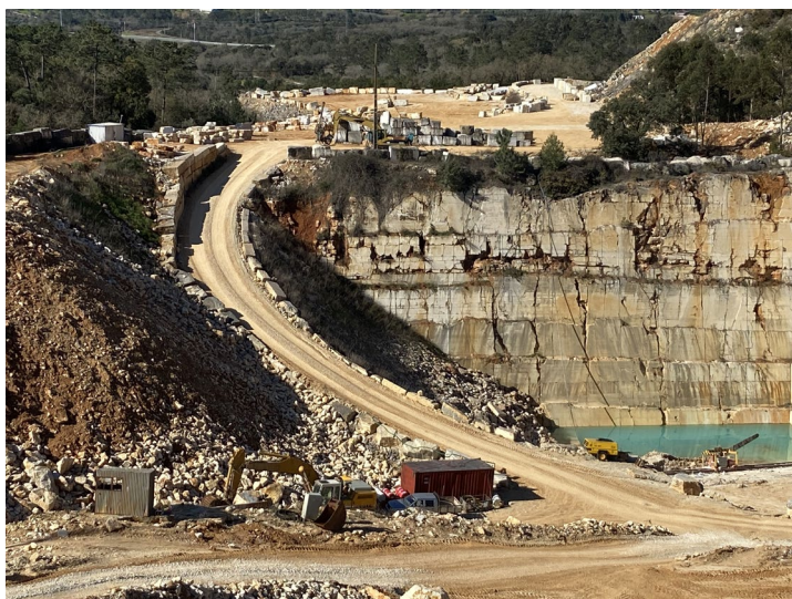
Foto 6 – Rampa de acesso à área de ampliação afeta ao parque de blocos comerciais e à área de deposição de resíduos de extração.
