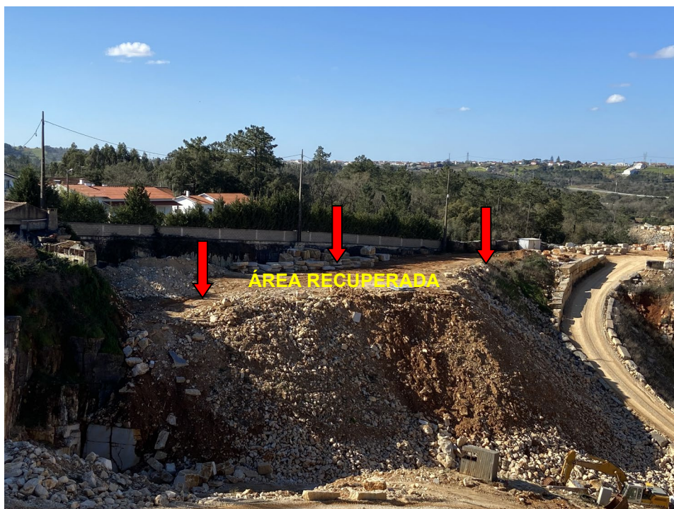
Foto 5 – Recuperação com enchimento do setor SW fora da área de lavra, junto do muro e da vegetação que separam a pedreira das casas próximas.
