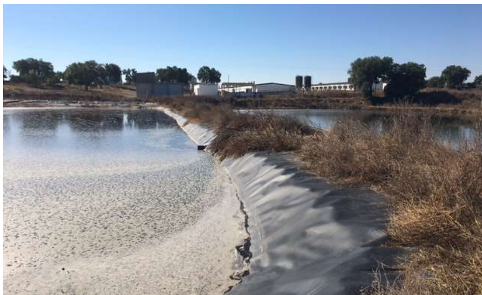
Figura III. 23 – Sistema de retenção de efluentes líquidos por lagunagem.
