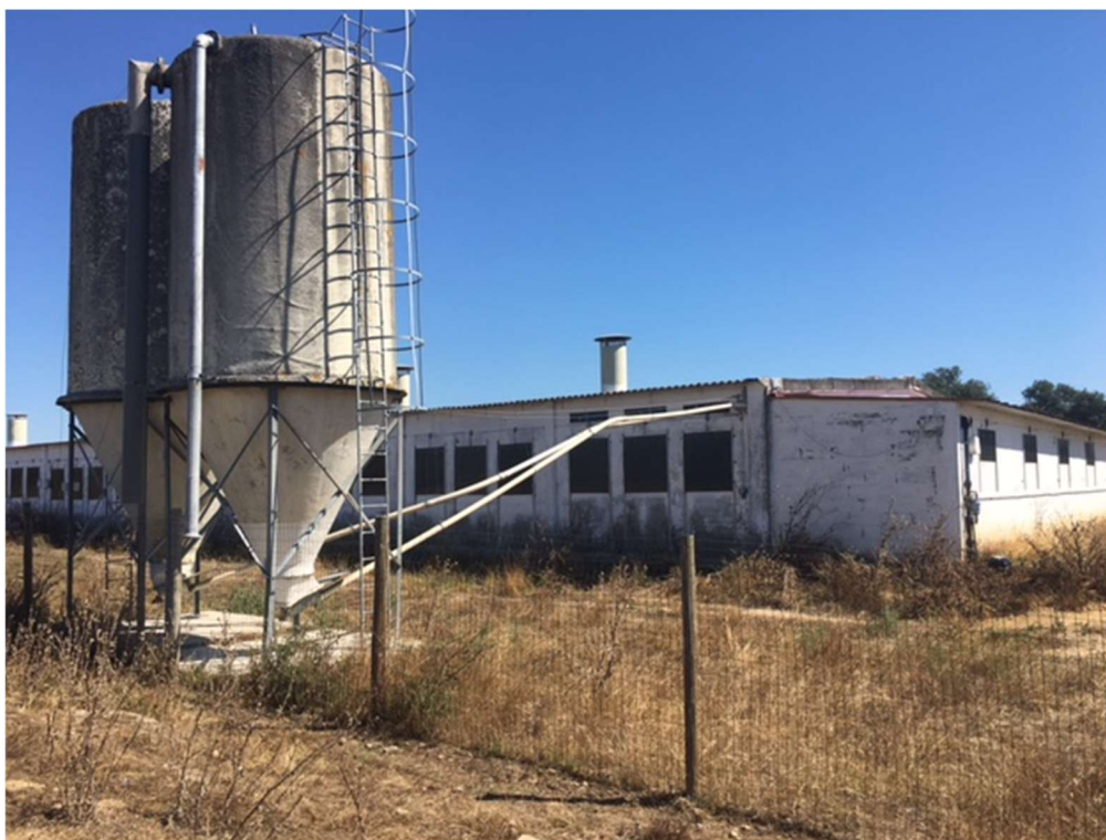
Figura II.2 - Silos de armazenamento de ração.
