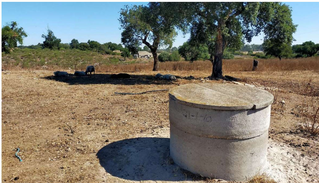
Figura III. 7 – Furo vertical em funcionamento na área de Projeto.
