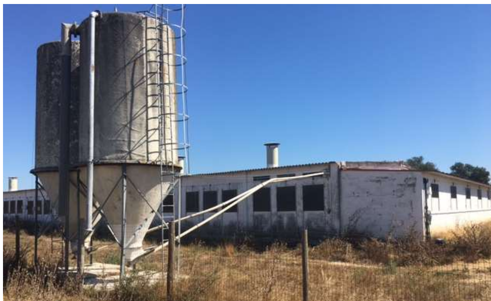
Figura III. 21 – Espaços edificados na área de projeto.
