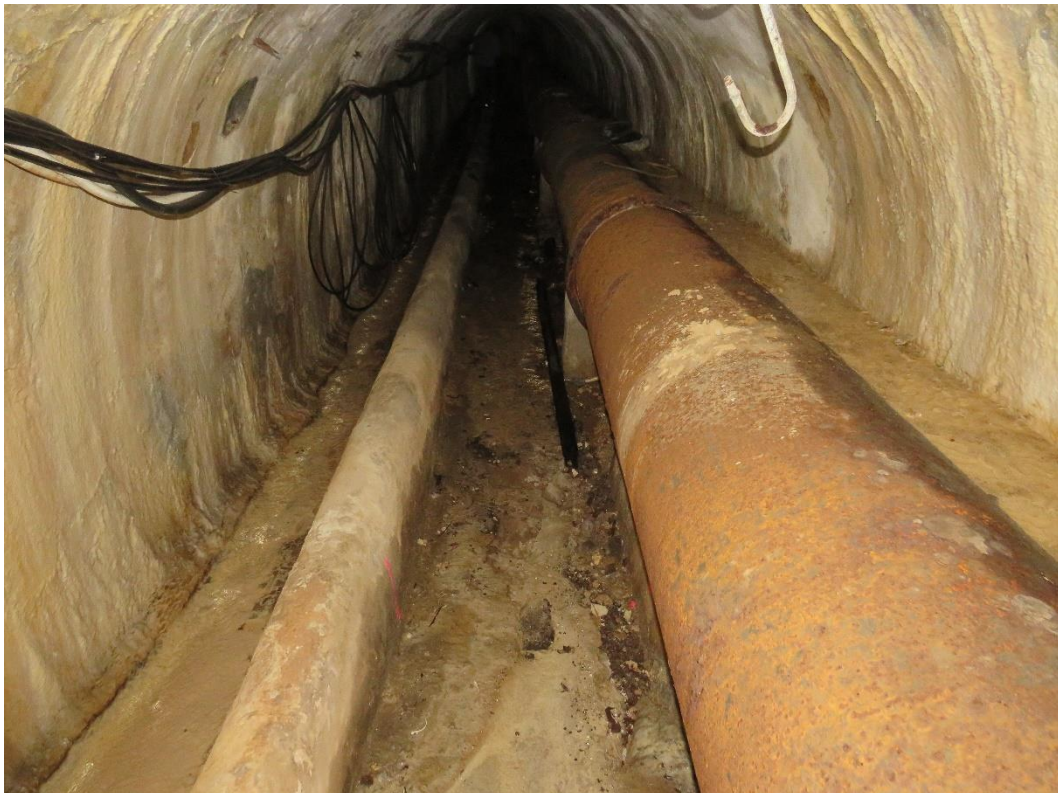
Foto 2 – Vista do interior do aqueduto na zona sobre o Eixo do túnel
