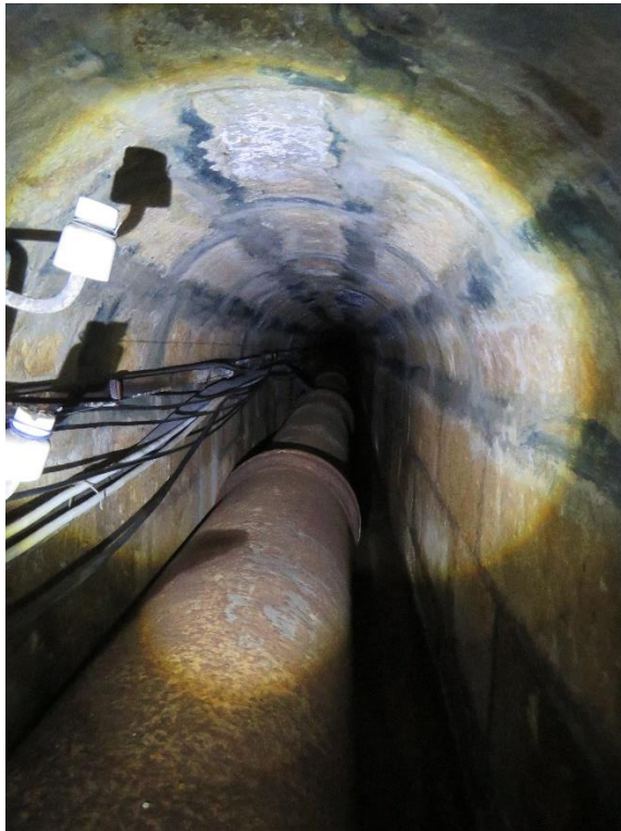
Foto 2 – Início nascente do Aqueduto junto escada vertical de acesso
