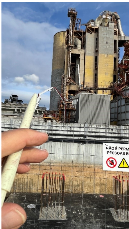
Fundações da estrutura para o transportador de tela do CA5 à torre do queimador auxiliar para alimentação ao forno 3
