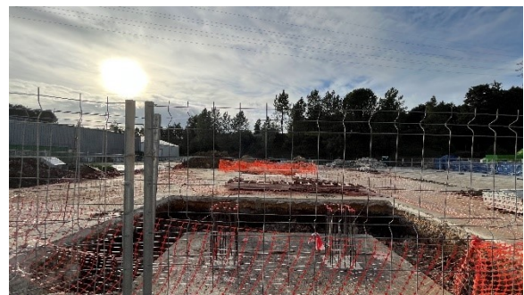
Construção do Armazém de combustíveis alternativos (CA5)
