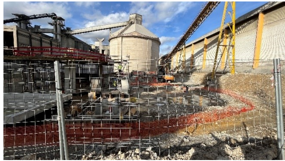
Construção dos silos 4 e 6 (CDR 2D e 3D)
