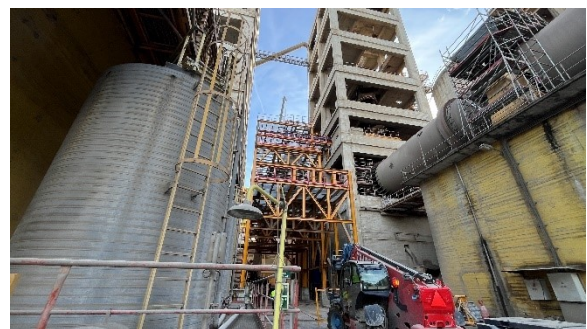
Secador de argilas, em construção, ao lado da torre de ciclones do forno 2
