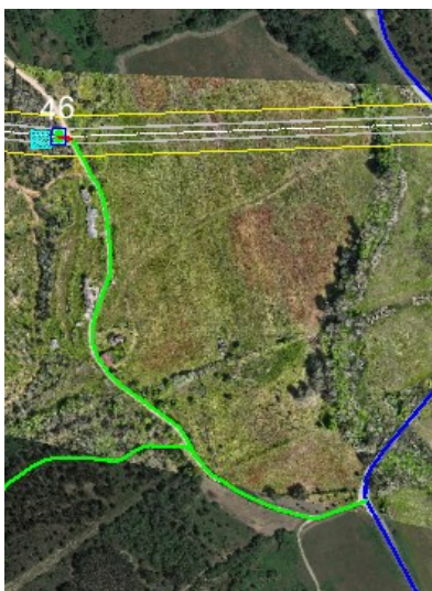
Figura 3.80 – Acesso ao apoio P46
