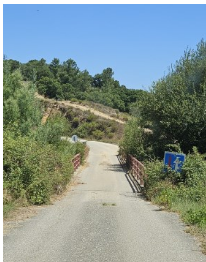
Figura 3.25 – Registo Fotográfico (acesso existente) P13
