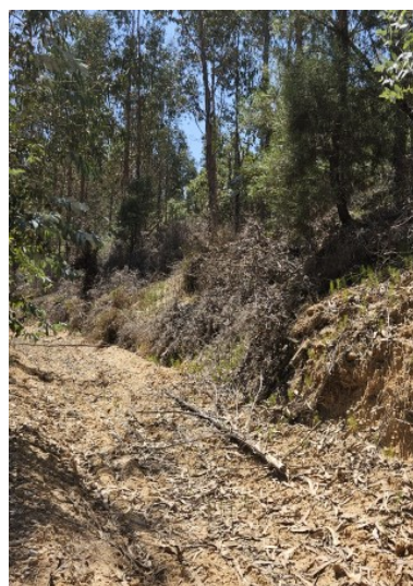
Figura 3.77 – Registo Fotográfico (acesso a criar) P44
