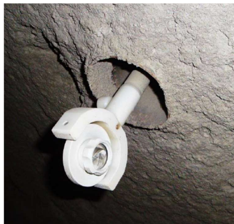
Figura 15 – Prisma de convergência
