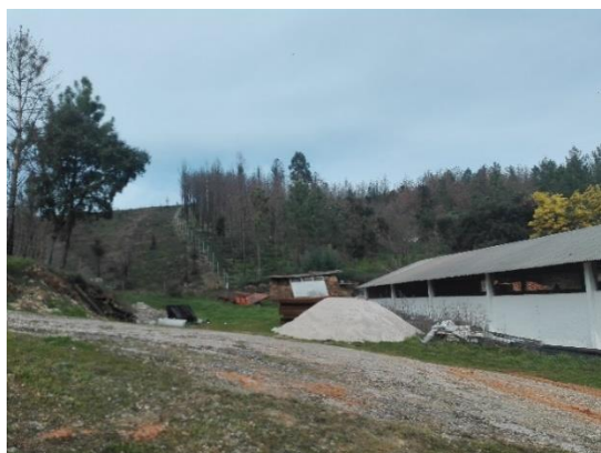
Figura 7.40 – Vista da área adjacente ao limite Nordeste da instalação avícola, enquadrada por floresta com espécies invasoras.
