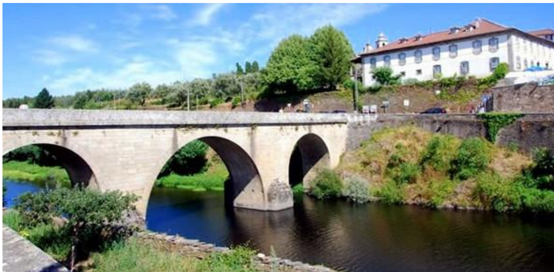
Figura 7.44 - Ponte sobre o rio Alva – Côja.
