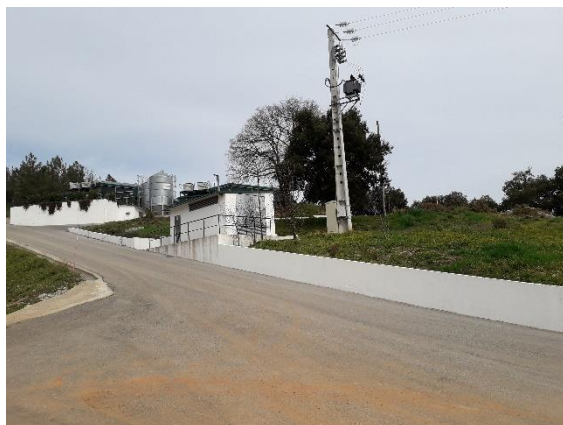
Figura 7.47 – Vista de um pavilhão localizado na do interior da instalação avícola e seus respectivos equipamentos de apoio.
