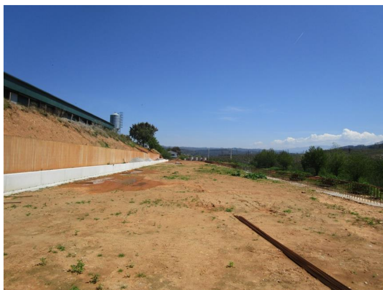
Figura 7.72 – Vista geral do terreno (plataforma para novo pavilhão)
