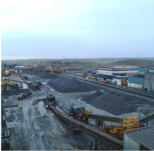
Figura 1: Vista do parque de minérios, com o sistema de deposição em pilha (stacker)
