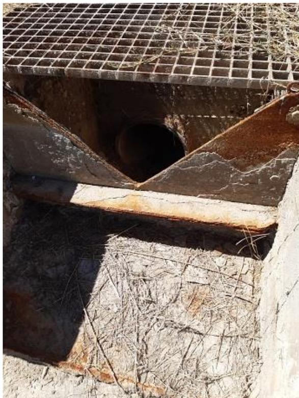
Figura 5: obra de descarga de águas industriais tratadas
