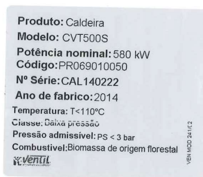
Foto 1: Placa identificativa do sistema de aquecimento existente na exploração
