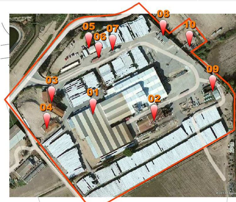
Figura 1 – Localização do edificado do estabelecimento.
