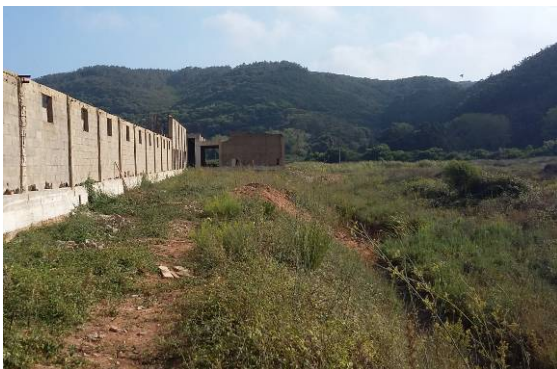
Fig 18 - Situação actual do talude
