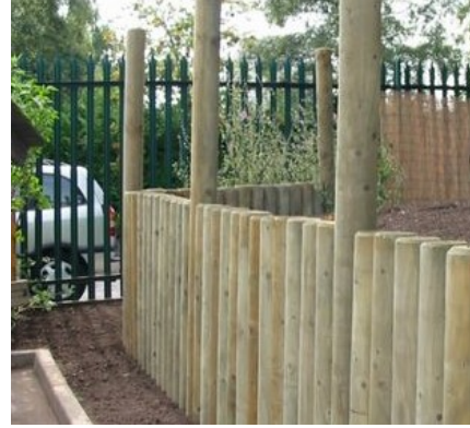
Fig 17 – Muro de suporte com postes de pinho
