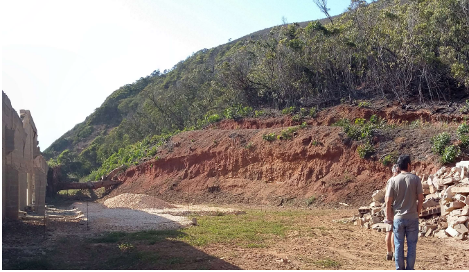
Fig 16 - Situação actual do talude
