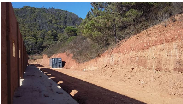
Fig 14 - Situação actual do talude
