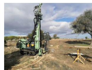
Figura 6 – Equipamento de perfuração utilizado na realização de sondagens geológicas.
