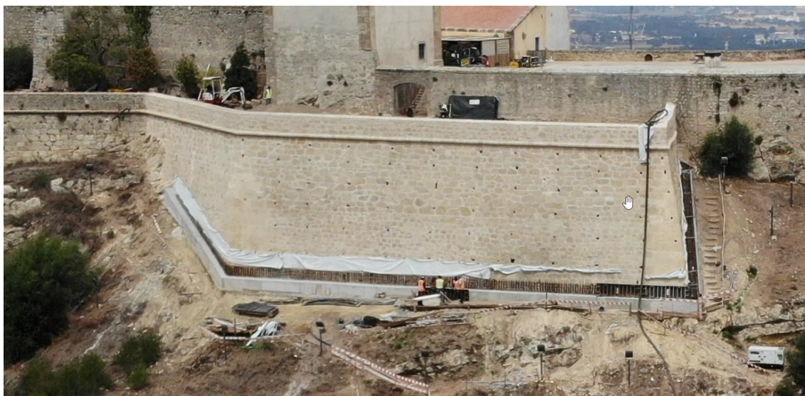
Figura 3.101 – Fotografia ilustrativa do tratamento proposto já executado noutra muralha histórica
