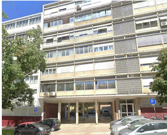
(a) Vista da passagem inferior sob o edifício n.º 59 da Av. Infante Santo
