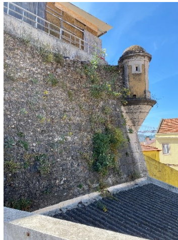
Figura 3.102 - Guarita existente na muralha do Baluarte em pedra
