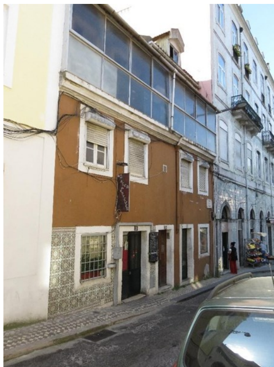
Figura 3 - Rua da Costa, 22-24-26 – interferência 389
