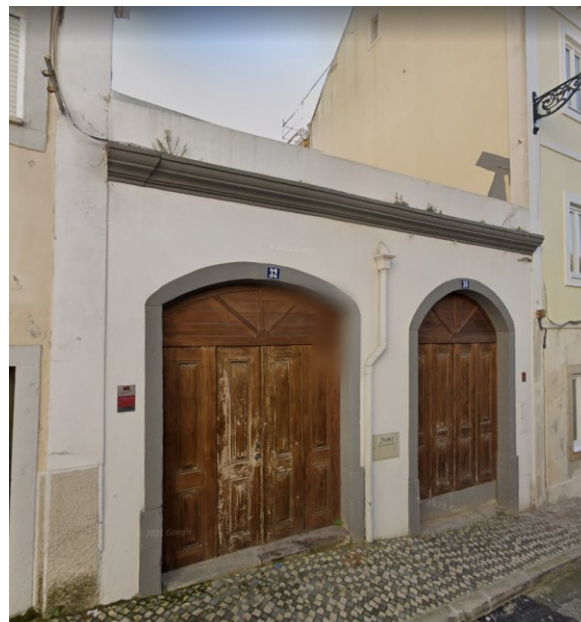
Figura 5 - Rua da Costa, 30-32 - interferência 391
