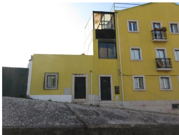
Figura 2 – Acesso à Ponte 25 de Abril, 2 – interferência 408
