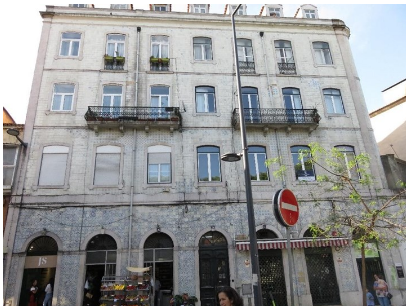
Figura 2 - Rua da Costa, 8-20 – interferência 388
