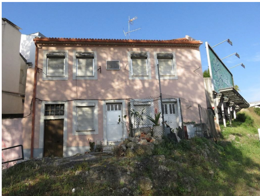
Figura 3 – Acesso à Ponte 25 de Abril, 7-11 – interferência 409
