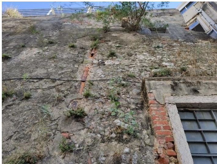
Figura 9 - Baluarte do Livramento – zona 2
