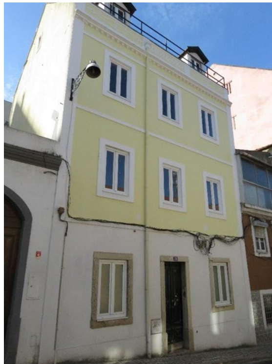
Figura 4 - Rua da Costa, 28 – interferência 390
