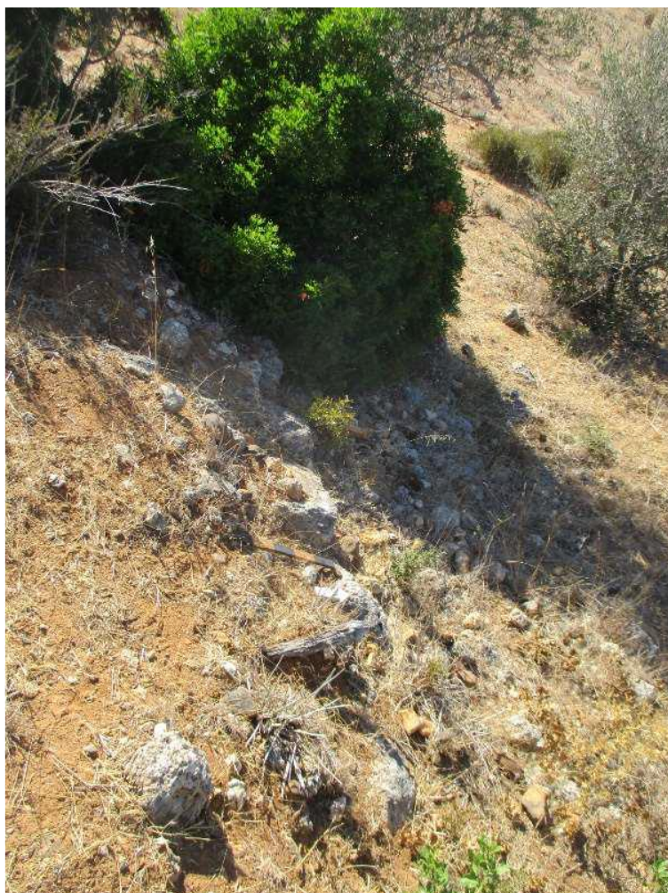
Fotografia 50 - Plano de muro de contenção situado a meio do vale a Norte da Quinta dos Arcos 3.
