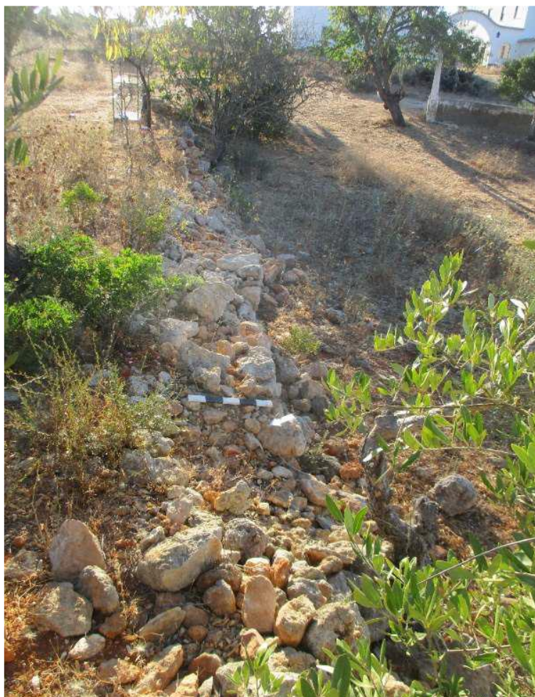
Fotografia 64 - Vista de plano de muros de contenção de terras na Quinta dos Poços 12.
