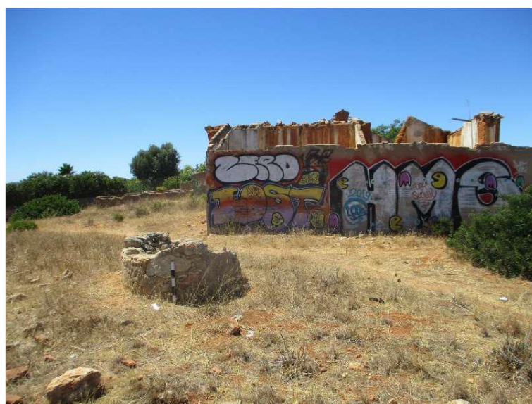
Fotografia 41 - Vista geral de possível estrutura de combustão a Este da Quinta dos Arcos.
