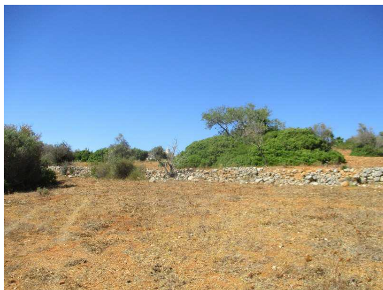
Fotografia 58 - Vista geral de muro de contenção de terras na Quinta dos Poços 11.
