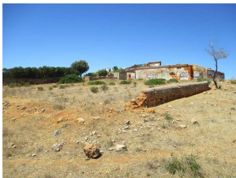
Fotografia 40 - Vista geral da Quinta dos Arcos e dos seus muros de divisão de propriedade.
