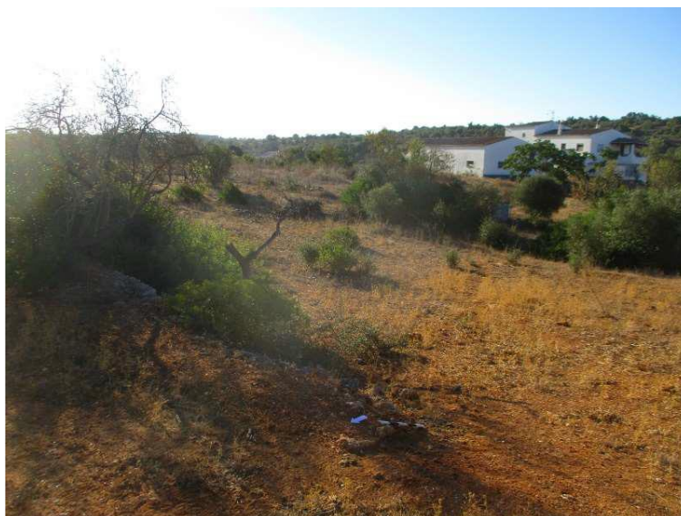
Fotografia 63 - Vista geral de muro de contenção coberto por vegetação, na Quinta dos Poços 12.
