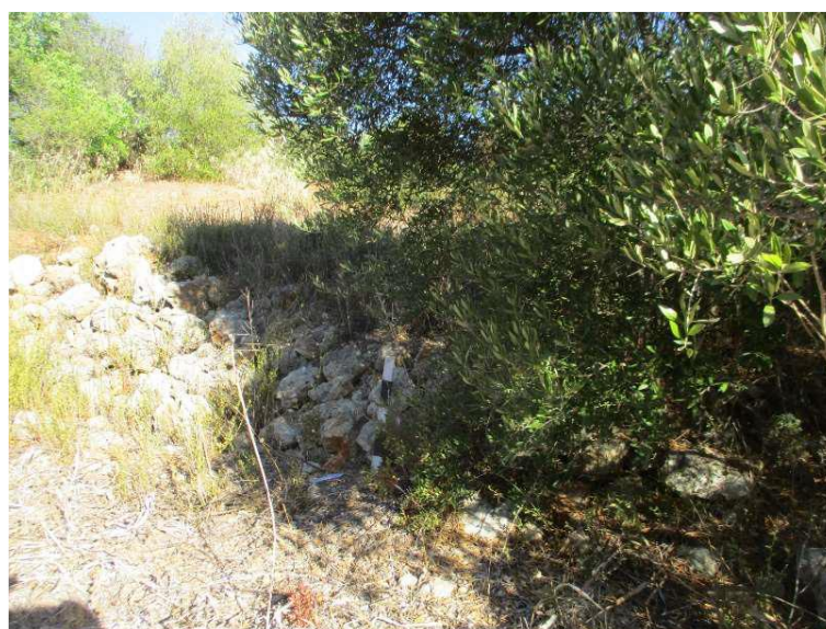
Fotografia 67 - Alçado Sul de muro de contenção de terras junto ao caminho, Quinta dos Poços 13.
