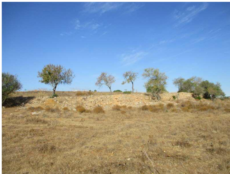
Fotografia 51 - Vista geral de muro de contenção de terra a delimitar a base Nordeste da colina a Nordeste da Quinta dos Arcos 3.
