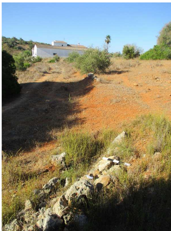
Fotografia 68 - Vista geral da localização de muros de contenção de terras junto ao caminho, Quinta dos Poços 13.
