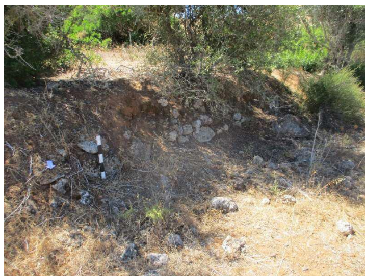
Fotografia 45 - Muro de contenção de terras na área Oeste da Quinta dos Arcos 2 (sitio 4).
