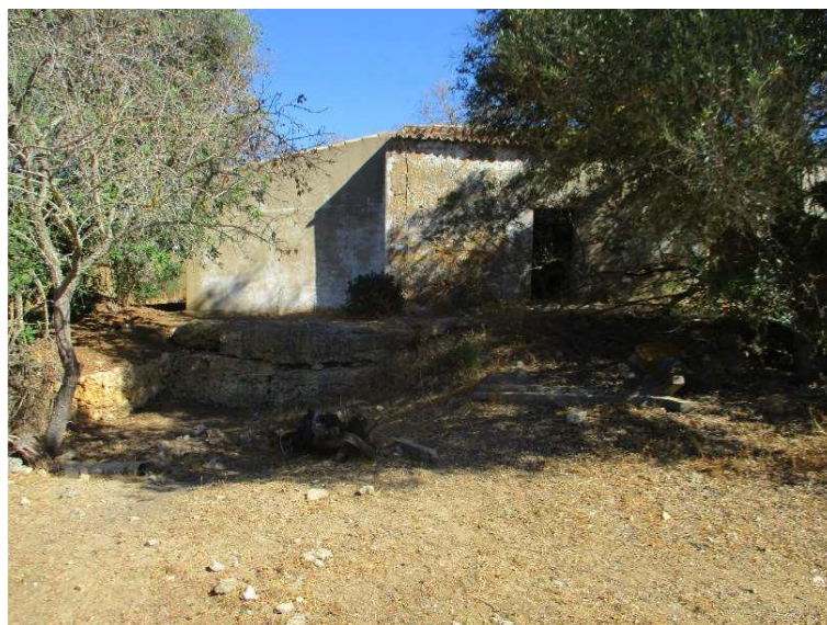
Fotografia 53 - Vista geral da entrada do casal Quinta dos Poços 10.
