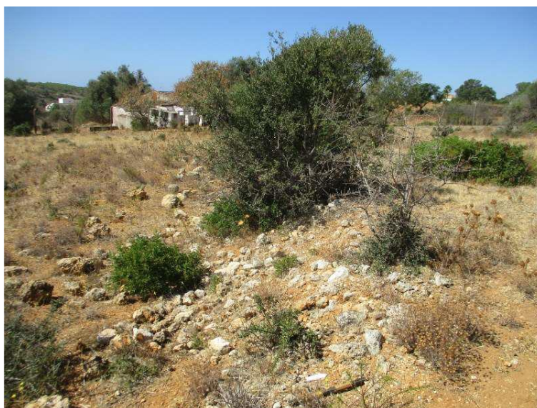
Fotografia 71 - Vista geral do plano do muro de contenção de terra na Quinta dos Poços 14.
