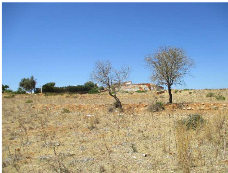
Fotografia 77 - Vista geral do muro de contenção de terras, Quinta dos Arcos 5.
