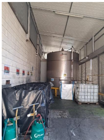
Figura 16. Área de armazenamento de resíduos perigosos, incluindo o tanque de emulsões oleosas
