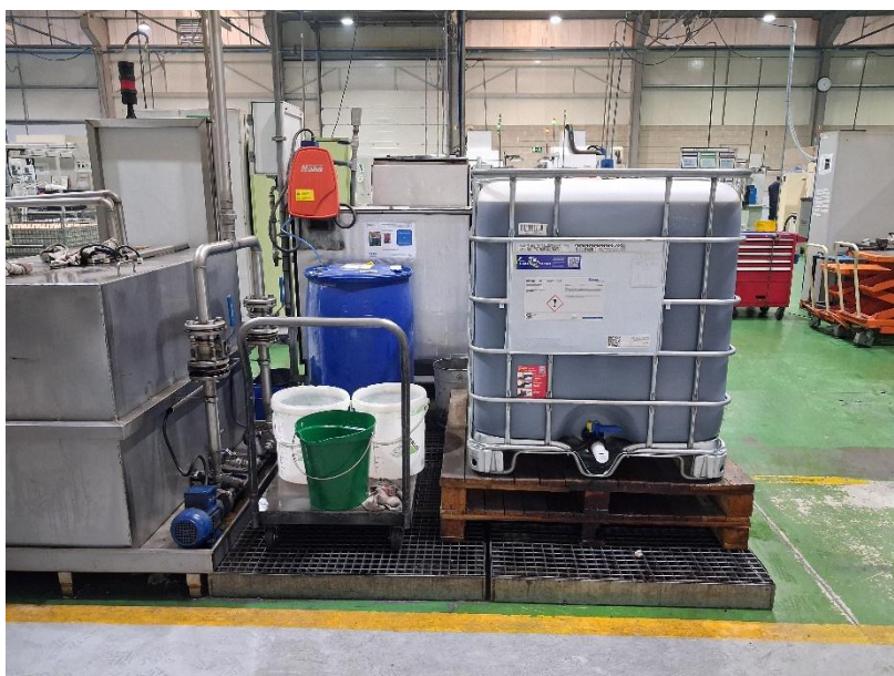
Figura 2. Armazenamento de substâncias perigosas no setor de maquinagem
