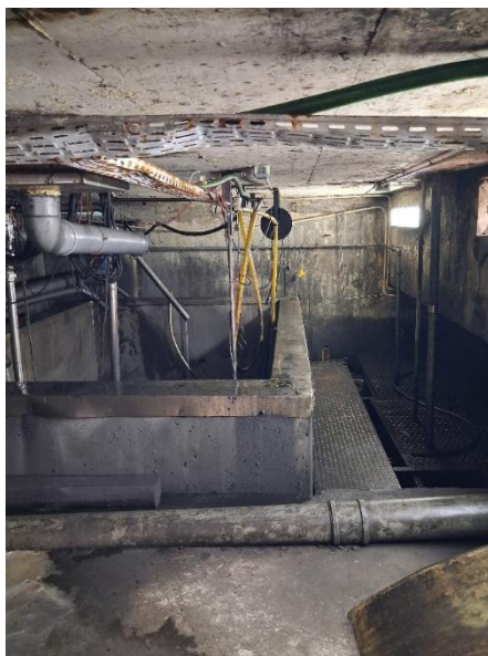
Figura 15. Área onde se localiza o Tanque de emulsões oleosas
