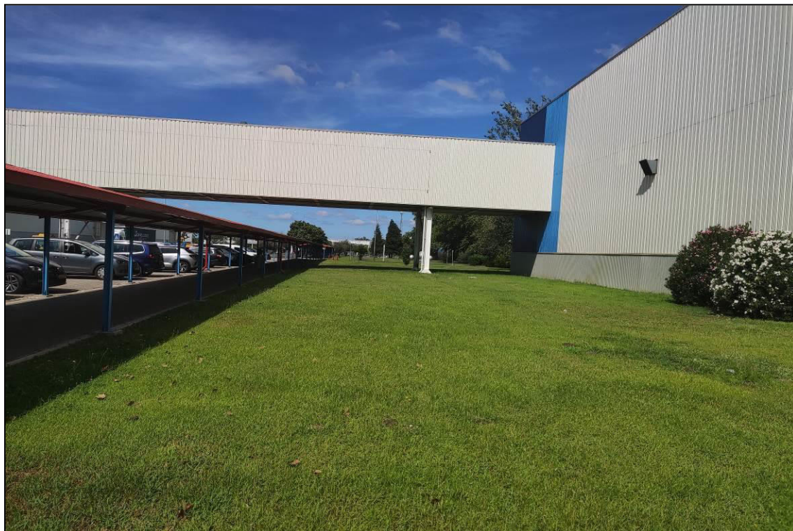
Foto 1 – Vista da zona ajardinada (extensão do edifício de pintura existente)
