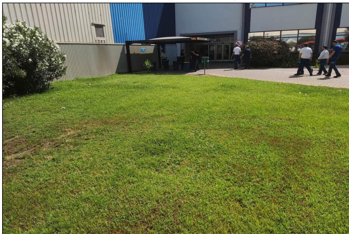
Foto 2 – Outra vista da mesma área ((extensão do edifício de pintura existente)
