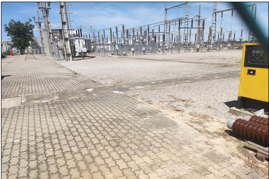
Foto 16 – Ampliação da Subestação
