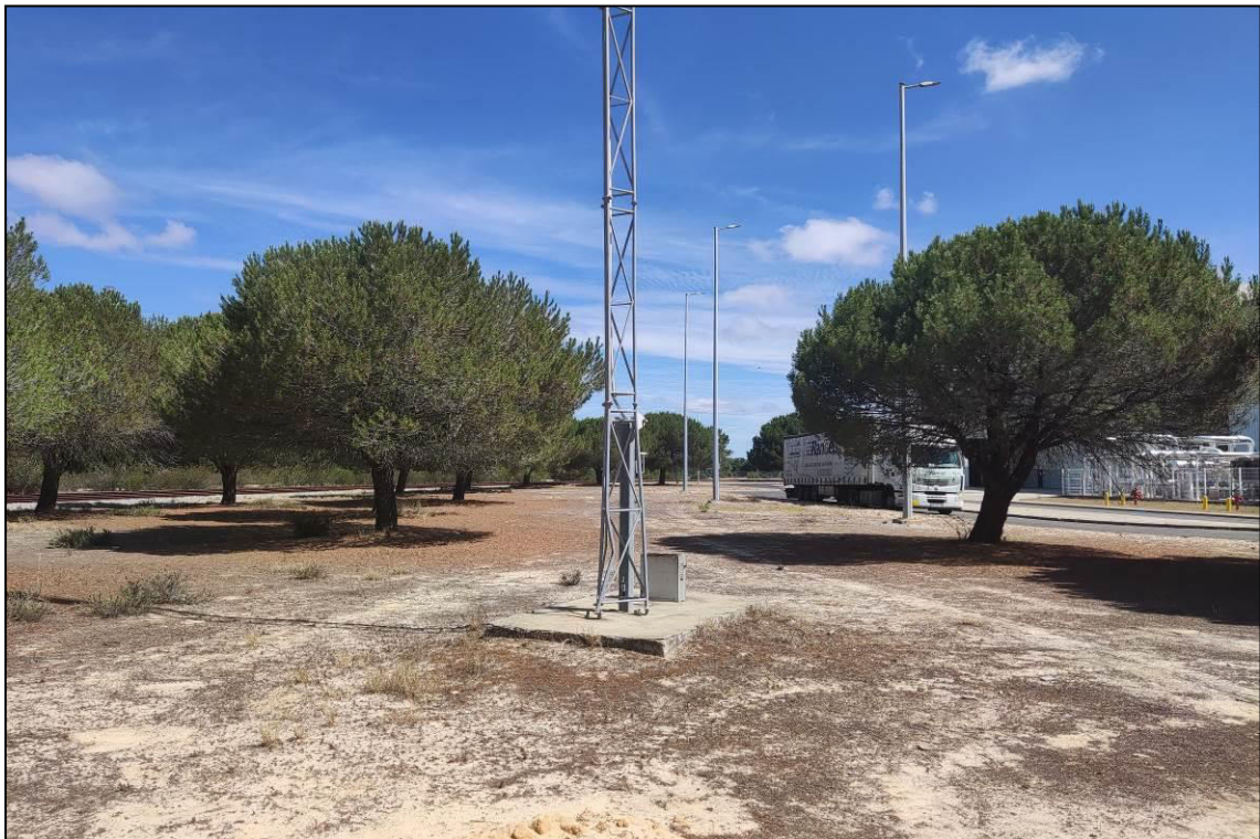
Foto 4 – Outra vista da mesma área (Nova Unidade de Pintura)
