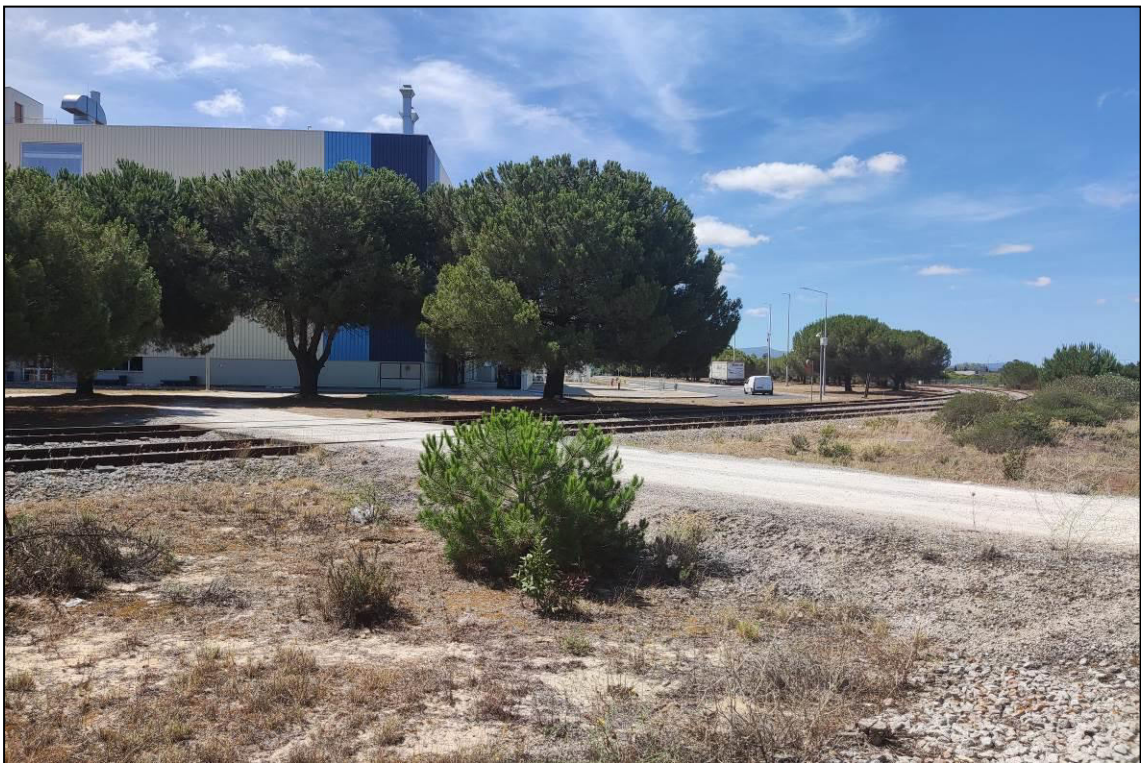
Foto 12 – Área de pinhal cortado por linha férrea (Estaleiro)
