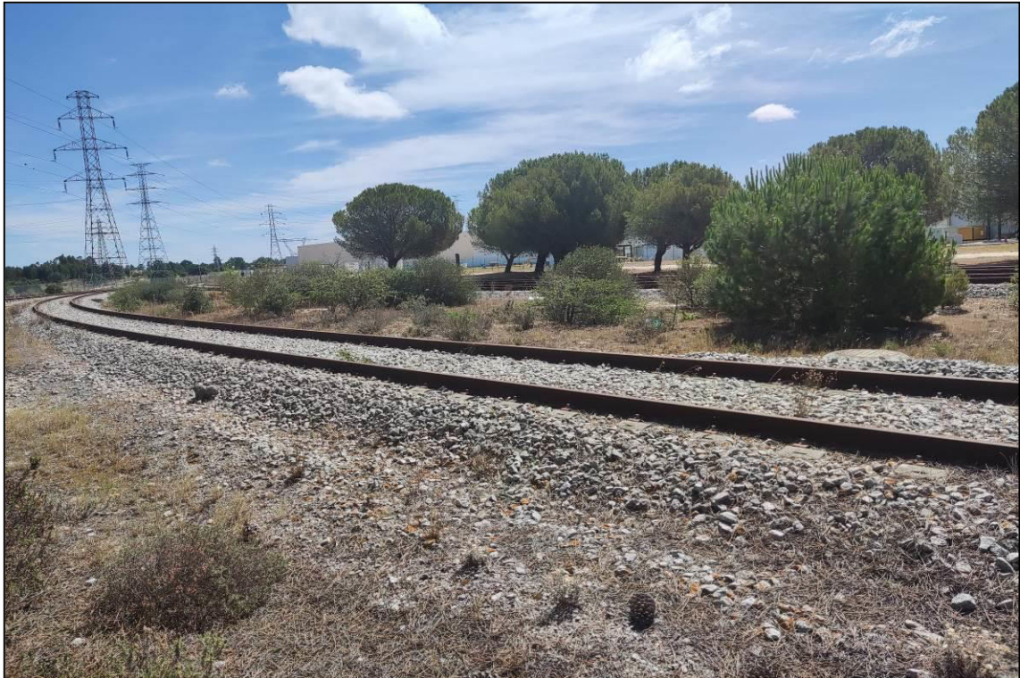
Foto 13 – Área de pinhal cortado por linha férrea (Estaleiro)
