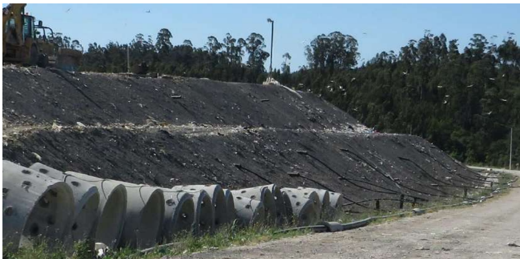
Figura 6-2- Extração do biogás do talude oeste da Célula B2, abril 2023
