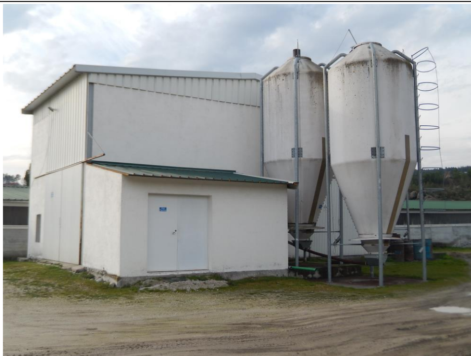
Figura 6- Edifício da Caldeira e Armazém de Combustível
