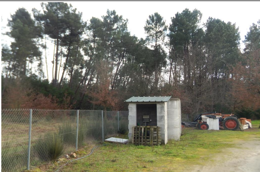
Figura 5- Casa da Bomba/Depósito Água
