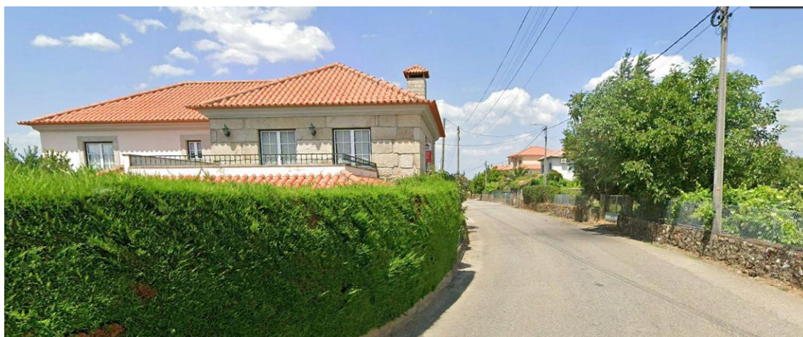
Aldeia de Cima (COS 2018V2 tecido edificado continuo) vista da rua da Carreirinha
