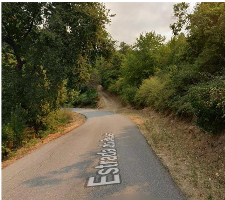
Fotografia 1- Troço de estrada da EN 226
