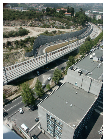
4. Lado sul: vias de maior dimensão. (Av. D. João IV e Rua Eduardo de Almeida)
