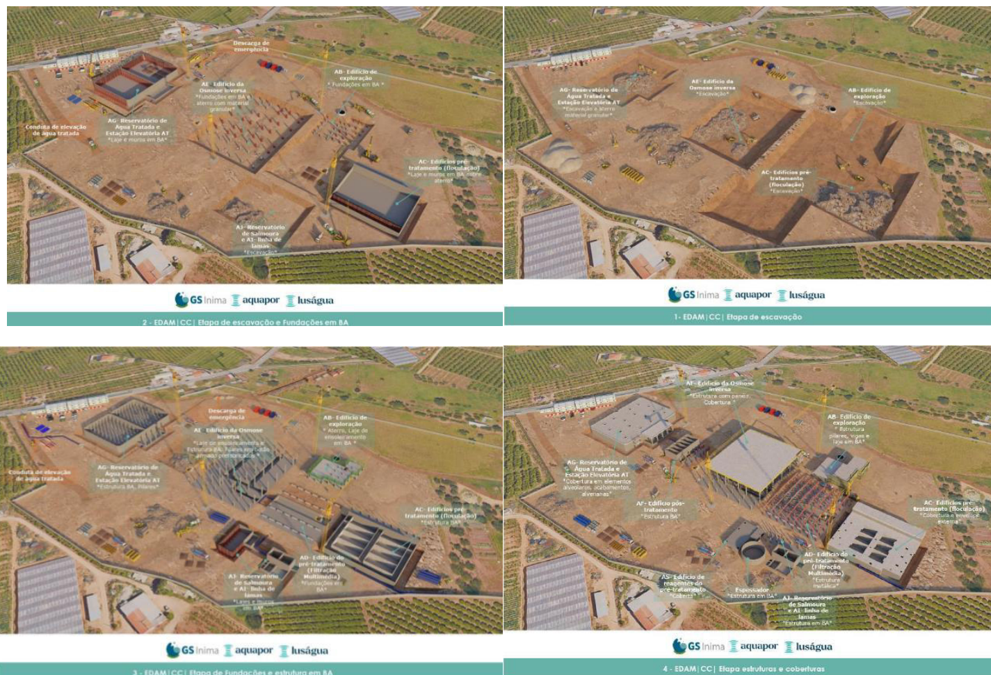
Figura 3.20 –Etapas de construção da EDAM (GS INIMA-LUSÁGUA-AQUAPOR)
