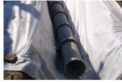
DRENOS EM MANILHAS DE BETÃO PERFORADO
