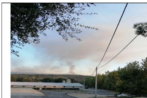
Figura 7.48 – Vista para ocupação industrial (instalação avícola em estudo)
