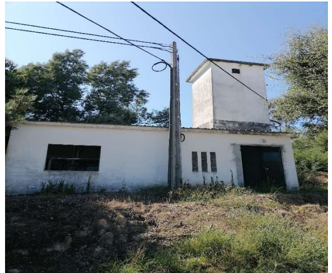
Figura 6.2 – Vista para as edificações da instalação
