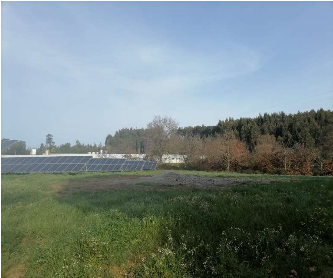
Figura 6.1 – Vista para o local dos novos pavilhões
