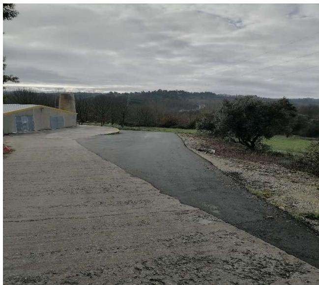
Figura 6.5 – Vista para os acessos no interior da instalação
