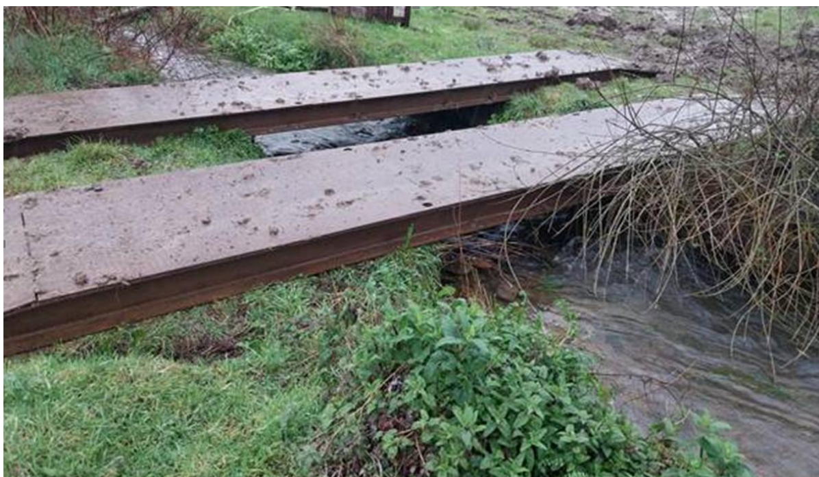
Figura 5 – Exemplo de chapa metálica, com mínima intrusão
