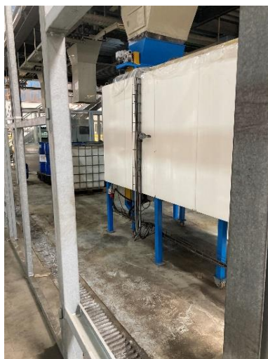
Figura 25 – Valeta de drenagem na unidade de eco-galvanização.
