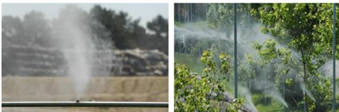
Figura 8 - Sistema de desodorização.
