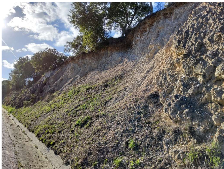
Foto 2 – Afloramento de conglomerados pertencentes à Formação \phi_{VG} ao km 42+620 (LE)
