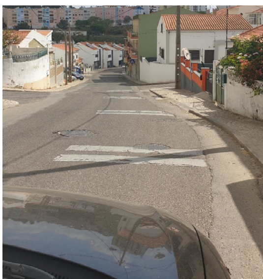
Fotografia 1 – Rua Batalha do Viso
