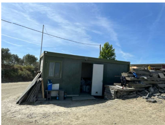
Figura 10: Fotografia do contentor utilizado para escritório e arrumos onde é atualmente efetuado o armazenamento dos óleos.
