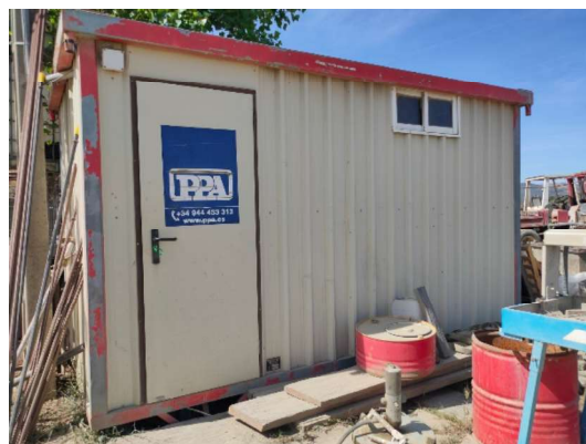
Edifício com sanitários e vestiários
