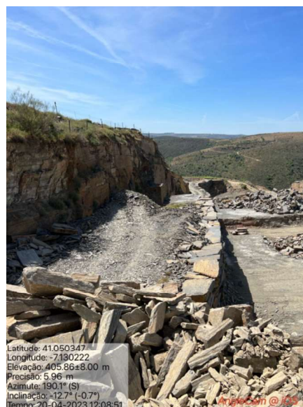
Figura 5: Fotografias do patamar implementado evidenciando a implementação da medida de suavização e estabilização dos taludes de inclinação acentuada com a criação de um patamar elevado na base.
