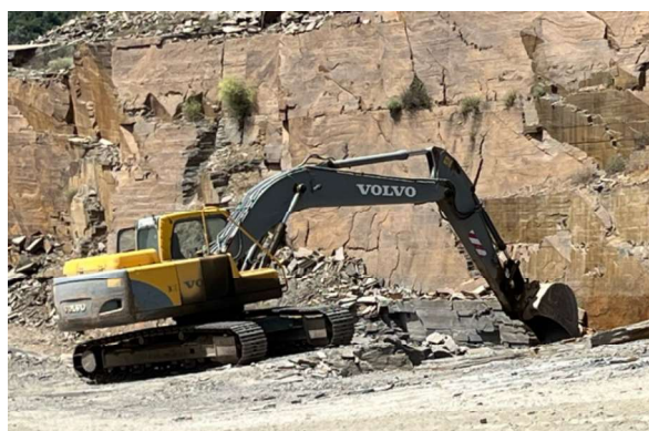
Escavadora giratória (Volvo)
