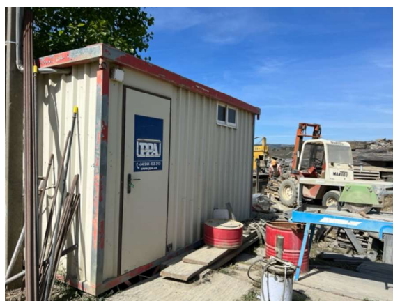
Figura 24: Fotografia do contentor utilizado para o escritório e arrumos e do contentor utilizado para as instalações sanitárias e balneário.
