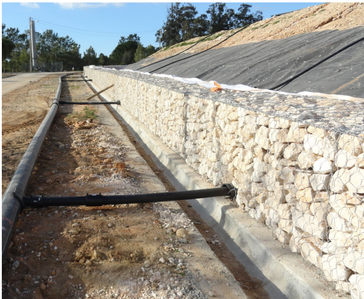
Figura 3 – Muro de gabião periférico realizado aquando da requalificação em 2013
