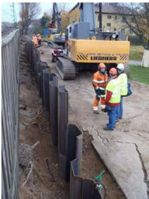
Figura 6 – Exemplo de barreira de vibração constituída por linha de folhas de aço (Graph 31 do documento UIC)
