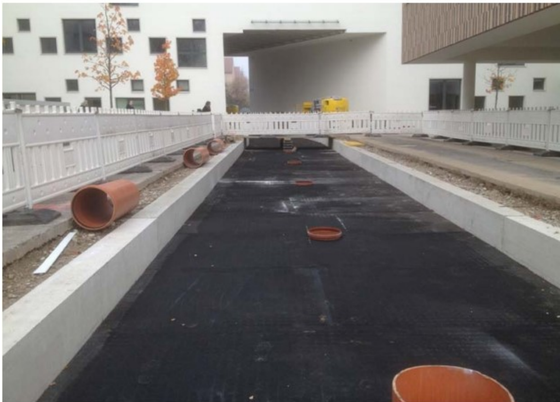
Figura 5 – Exemplo de manta anti vibrátil (Graph 22 do documento UIC)
