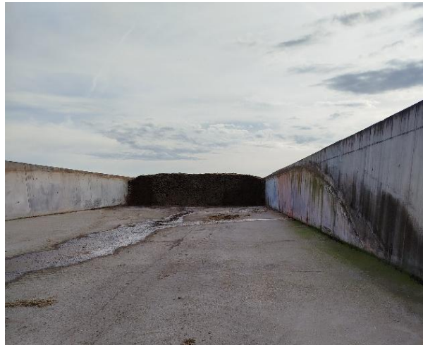
Fotografia 2.2 - Exemplo de plataforma tipo silo exterior para armazenamento de vegetais
