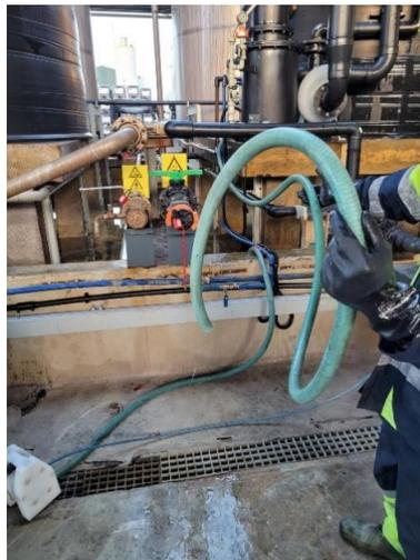
6.1.2. Abrir a válvula de fundo e retirar toda a água do lavador.
