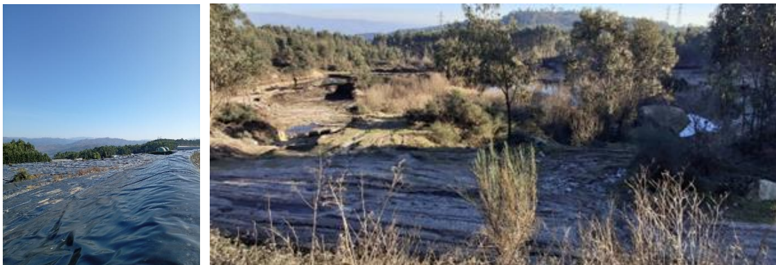
Figura 6 - Perspetiva geral da área de reengenharia (à esquerda) e da área de ampliação do aterro (à direita).
