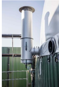
Figura 36. Válvula de segurança.
