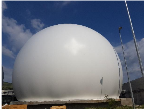
Figura 34. Exemplo de um gasômetro de chão.
