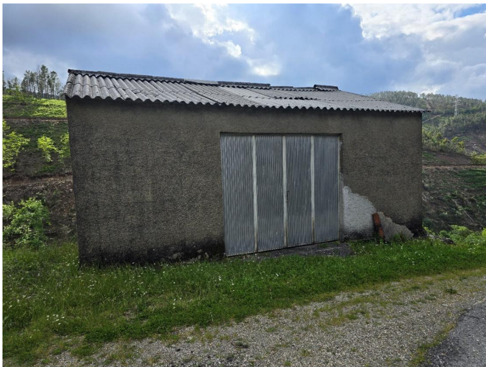
Figura 5 – Instalações agrícolas (pequeno apoio agrícola)
