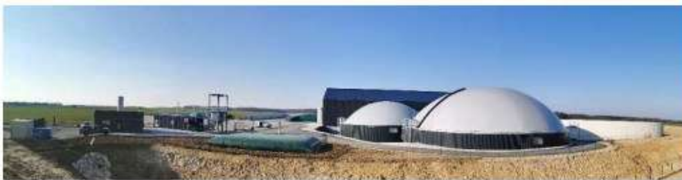
Exemplo de digestores
