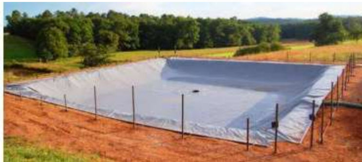
Exemplo de lagoa coberta-digerido
