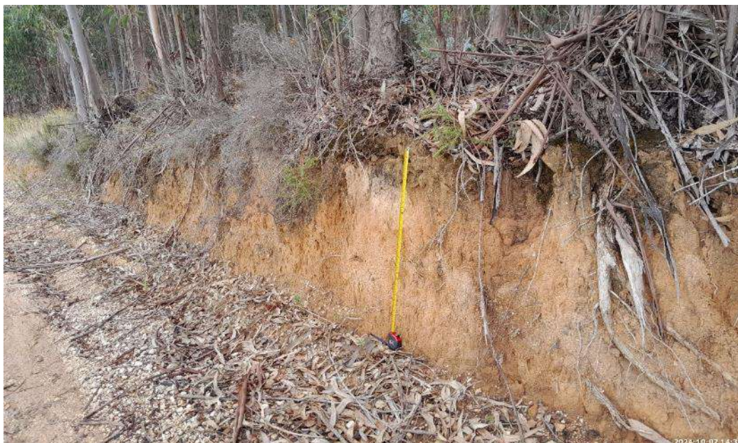
Figura 18 - Talude de escavação situado no caminho que marca o limite norte da propriedade.
