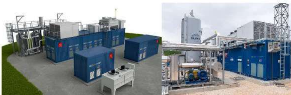
Exemplo de posto de entrega do biometano para injeção da rede
