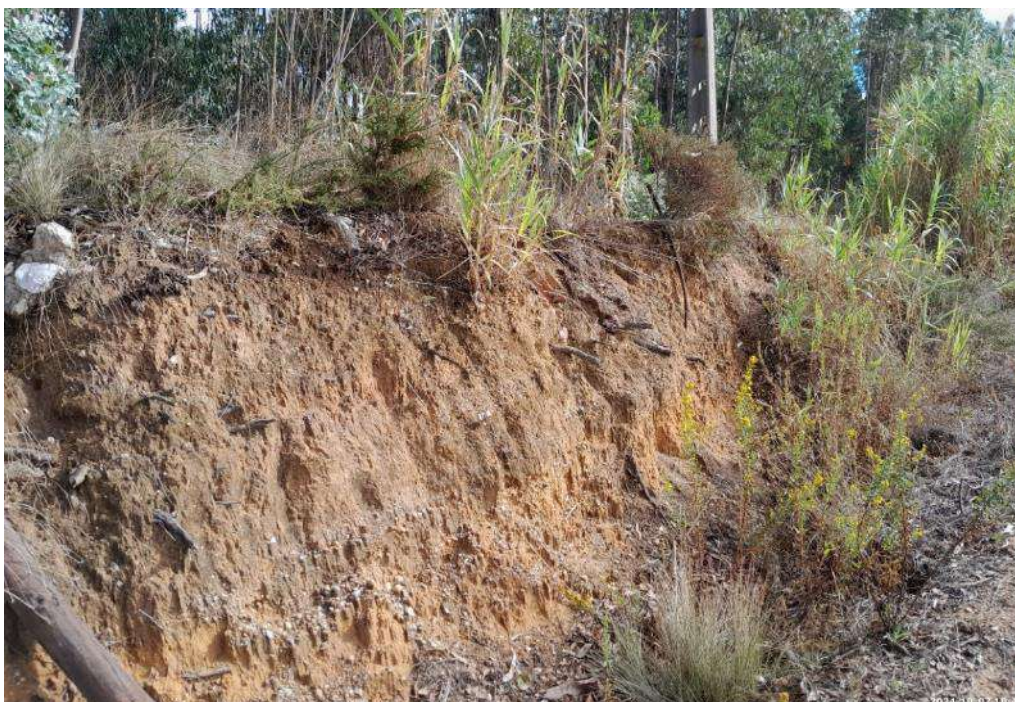
Figura 17 – Talude de escavação situado no caminho que marca o limite norte da propriedade.
