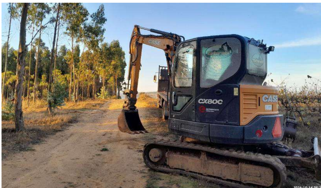
Figura 21 – Retroescavadora utilizada na abertura dos poços de reconhecimento
