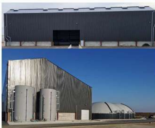
Exemplo de um edifício de exploração
