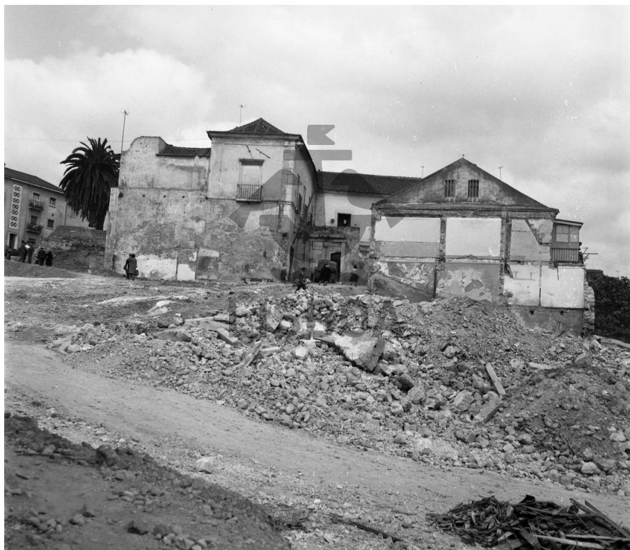
Figura 420 – Demolição do bloco sul do palácio Fiúza em 1966, na sequência da construção do acesso à Ponte 25 de Abril. A fachada que se observa na imagem foi a que se manteve até ao presente.
