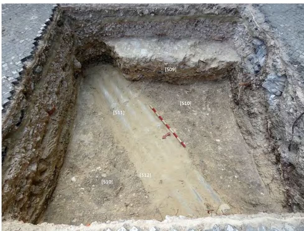
Figura 344 – Identificação de infraestrutura composta por manilhas de betão.
