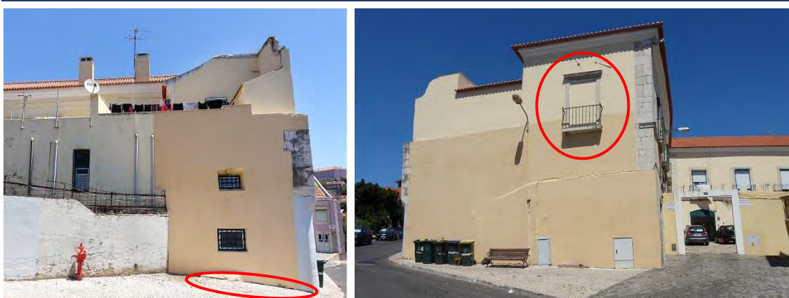
Figura 432 e 433 – Fachada poente junto da qual foi realizada a sondagem e fachada nascente onde se mantém a janela entaipada e varandim que se observava antes das obras dos anos sessenta.
