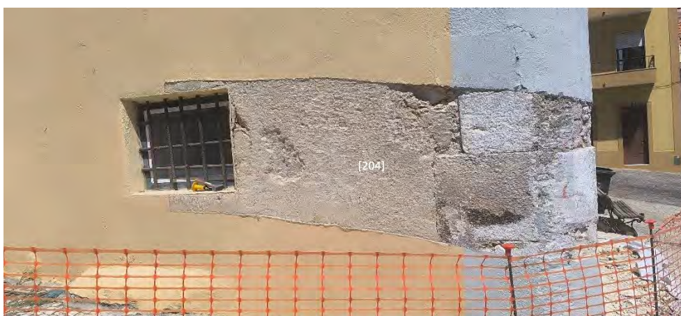
Figura 443 – Unidade [204] composta por argamassa cimentícia.
