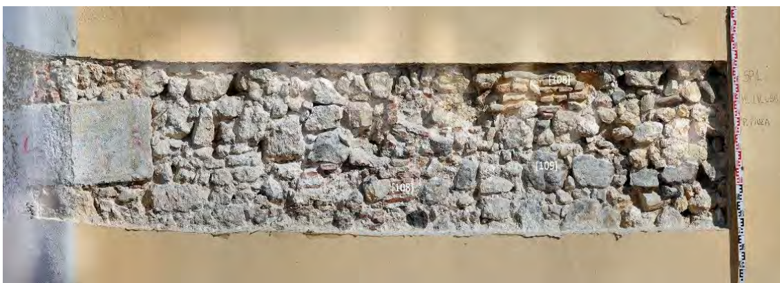
Figura 440 – Plano final da SP1 onde se observa o aparelho construtivo da fachada.
