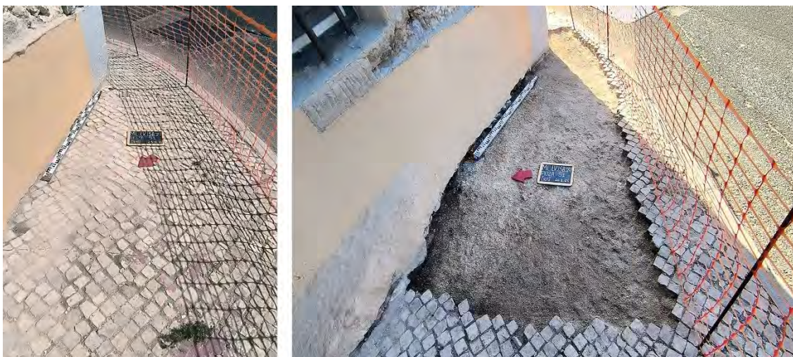
Figura 425 e 426 – Local de intervenção com a calçada [100] e camada subsequente [101].
