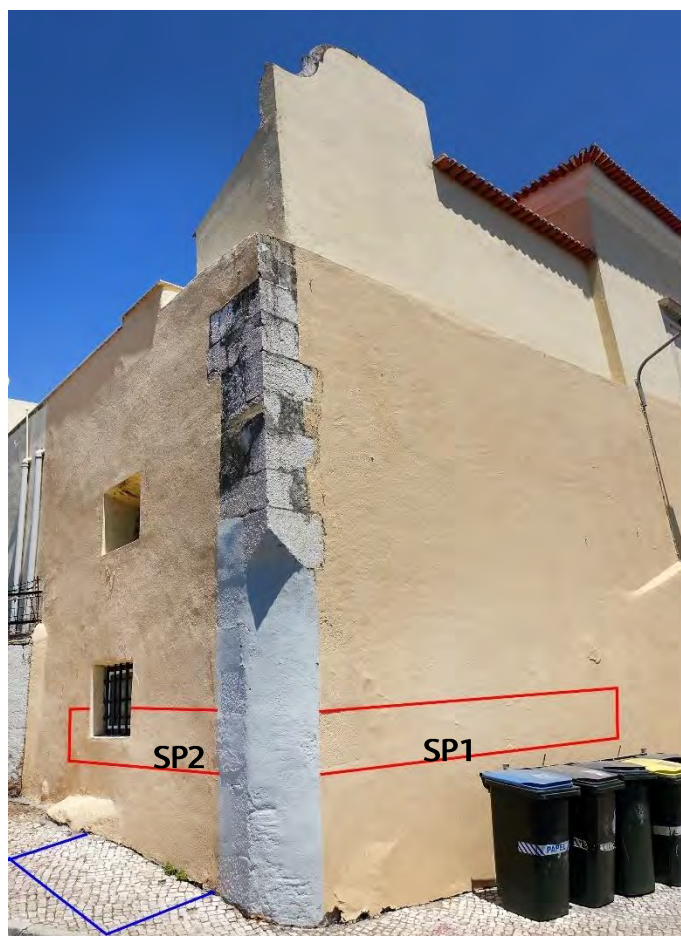
Figura 435 – Disposição das sondagens parietais, a vermelho, e da sondagem arqueológica, a azul, junto do cunhal sul do edifício.
