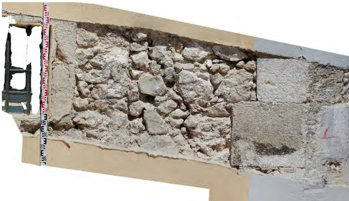
Figura 445 – Fotogrametria do plano final da SP2 com o aparelho construtivo, [208], a descoberto
