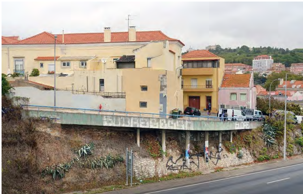
Figura 431 – Pormenor da base em viaduto da estrada que passa junto da fachada do edifício.
