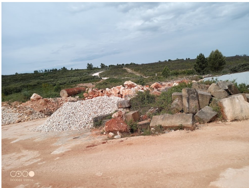
Figura 12 – Área de ampliação (zona não decapada)
