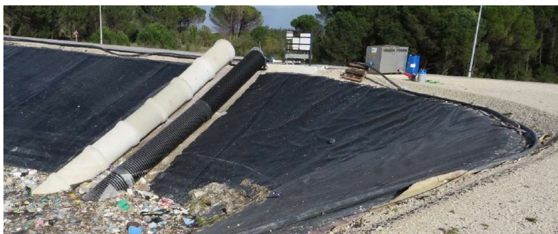
Figura 6-1 - Extração de lixiviados por bombagem na Fase B
