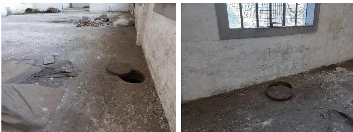
Figura 3.4 – Tomada de água do Tanque 3
