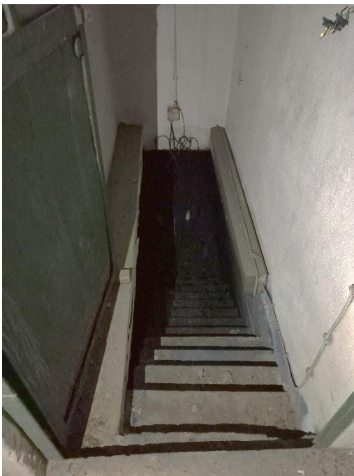
Figura 3.3 – Acesso ao Tanque 1
