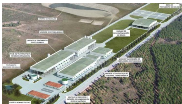
Figura 16 – Planta da instalação fabril.
