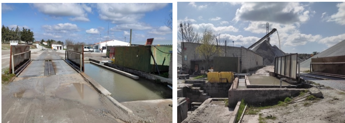
Figura 105: Fotografias do sistema de lavagem de rodados.
