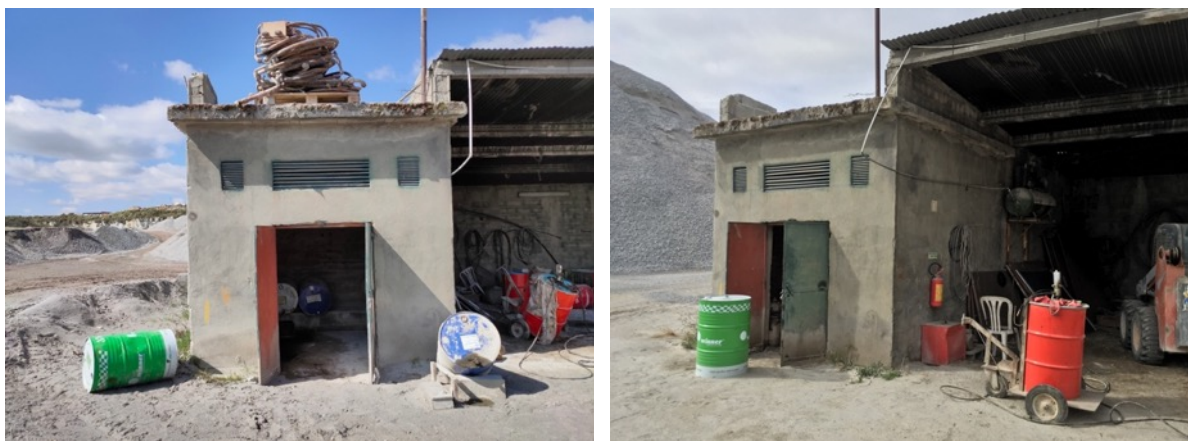
Figura 155: Registo fotográfico do local de armazenamento de óleos.
