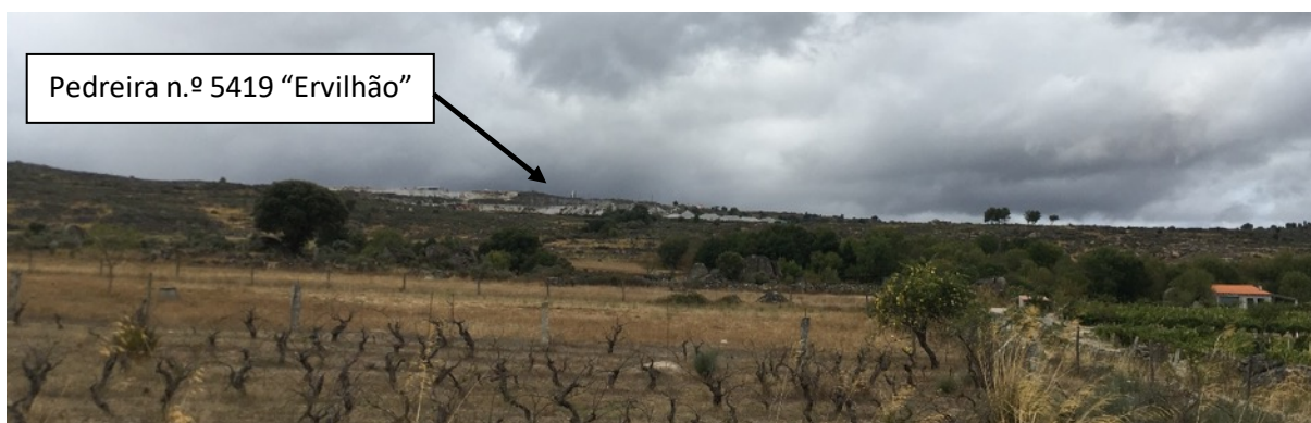
Figura 39: Ponto de observação PV8 (caminho rural, a oeste da pedreira n.º 5419 “Ervilhão”)
