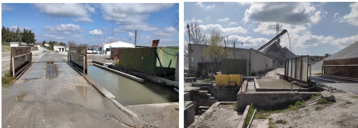
Figura 11: Fotografias do sistema de lavagem de rodados.
