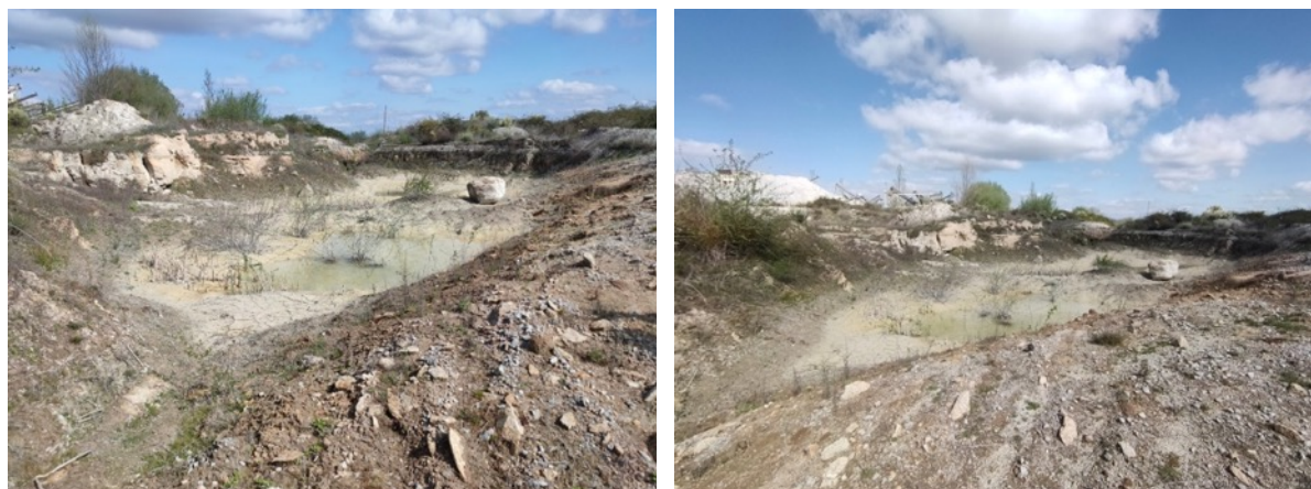
Figura 106: Fotografias da lagoa de decantação.
