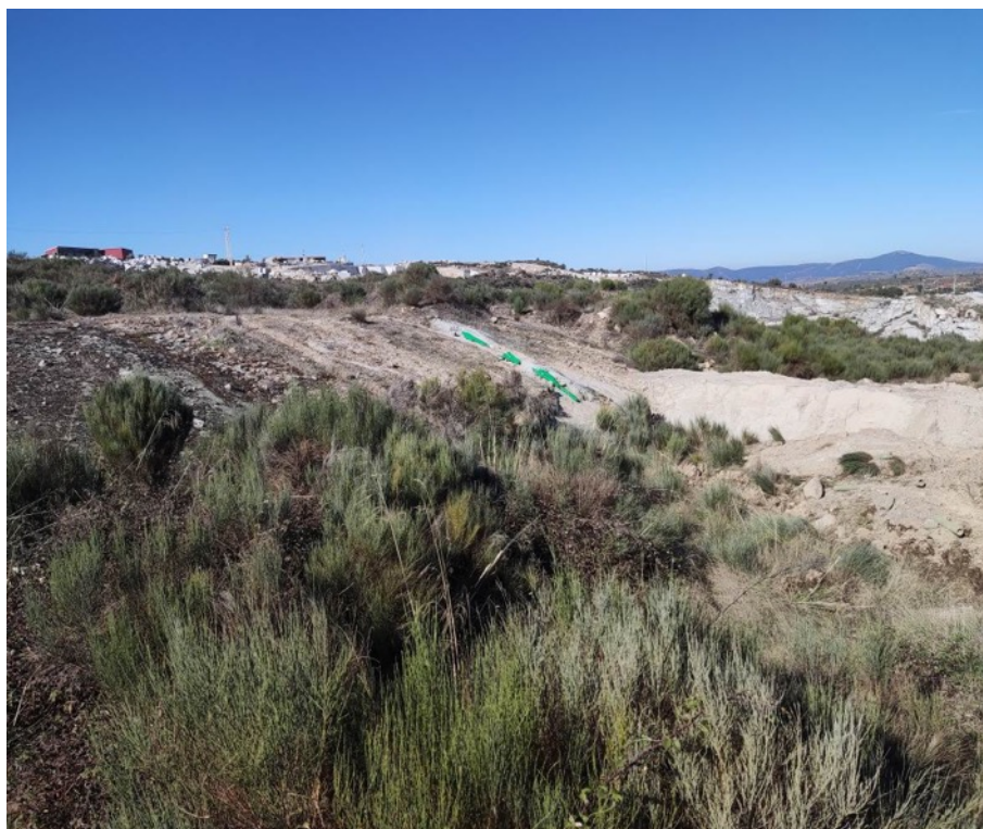
Figura 153: Vista da Área B, intervenção no solo para estruturas hidráulicas
