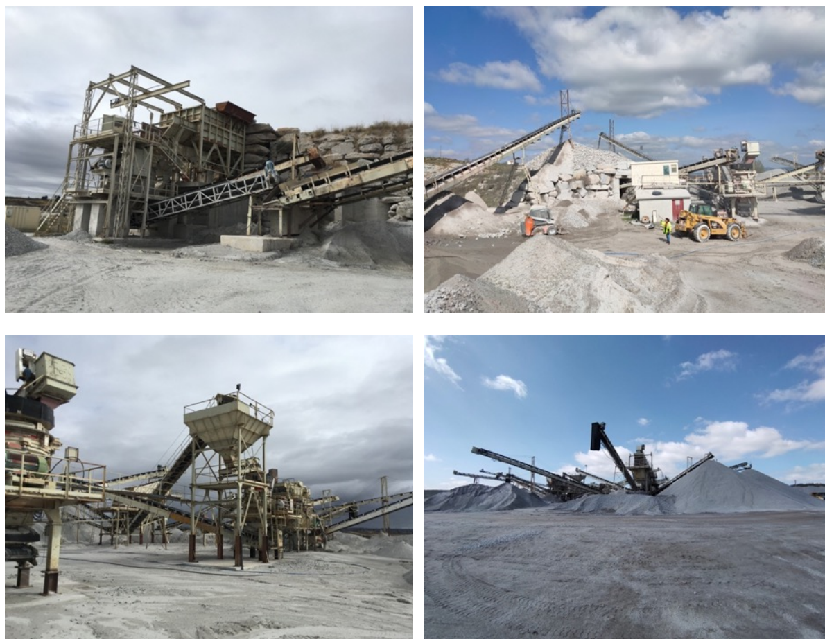
Figura 7: Fotografias da instalação de britagem.
