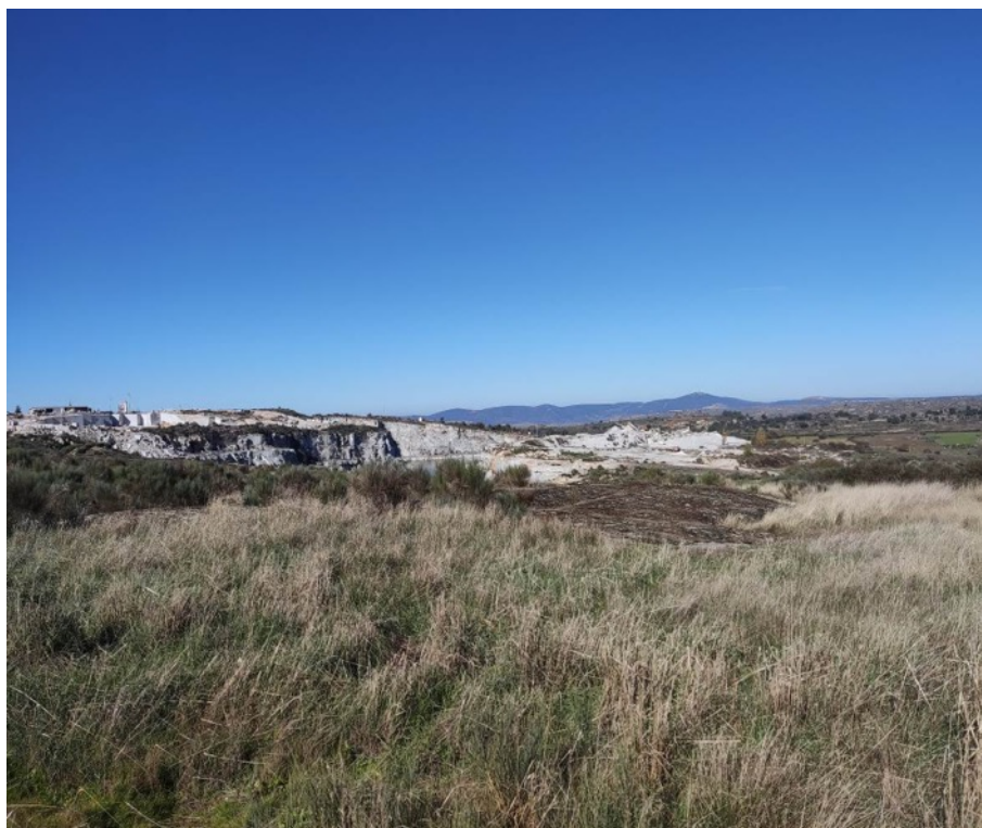
Figura 151: Vista da Área A, em segundo plano área já licenciada e Área B.
