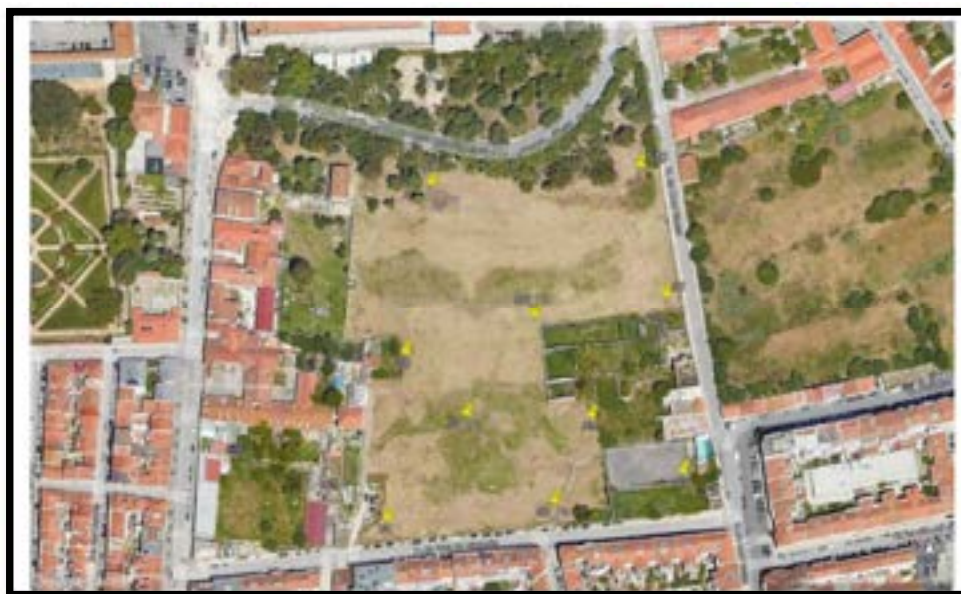
Figura 56 -Localização aproximada das sondagens S1 a S10 realizadas na área do loteamento
