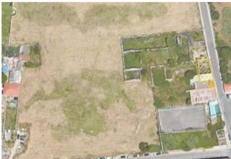
Figura 33 – Edificações a recuperar
