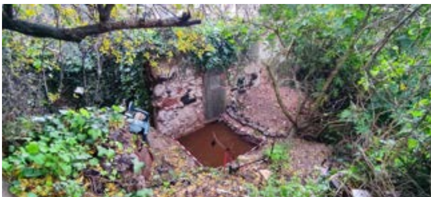
Fotografia 38 - Vista da área junto da fachada tardoz do edificado no canto SE da propriedade
