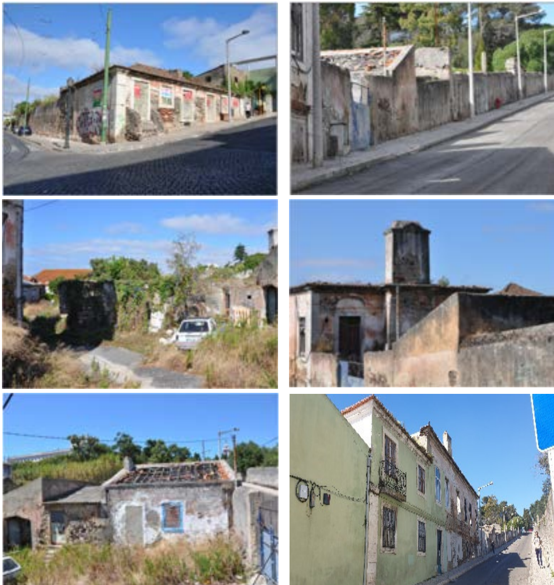
Fotografias 3 – Edificações a Demolir
