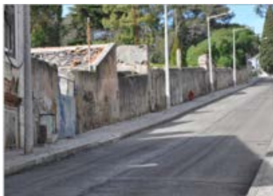
Fotografia 12 – Limite Este Edifícios devolutos (a demolir)
