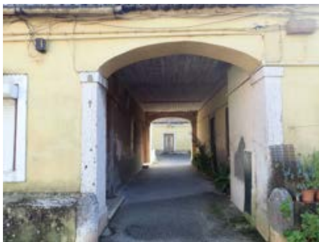
Fotografia 40 – Entrada do Túnel no Pátio do Bonfim, do lado Oeste.
