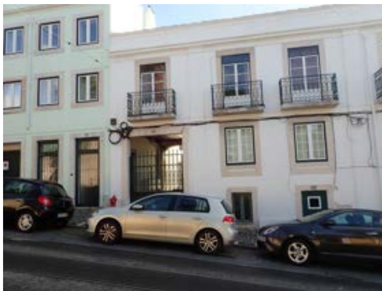
Fotografia 31 – Vista do edificado que integra o Pátio José Pincel.
