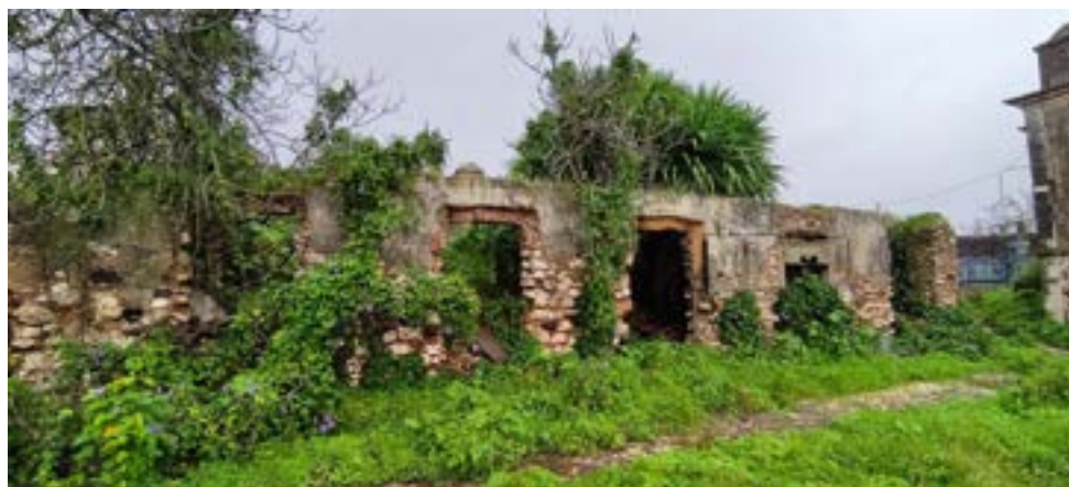
Fotografia 36 - Edificado anexo a NO do edifício principal
