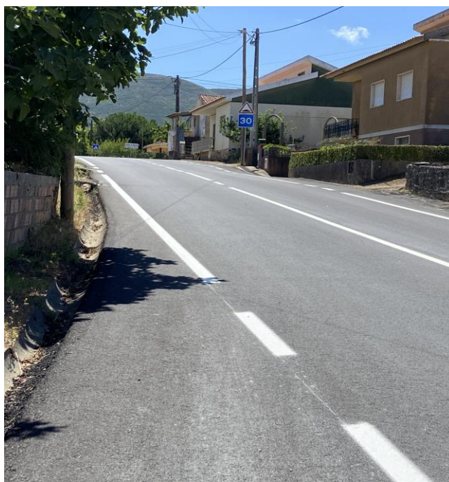
Foto 6 – Sinalização vertical na estrada Lagar dos Frades junto à entrada da pedreira – lombas e velocidade recomendada.
