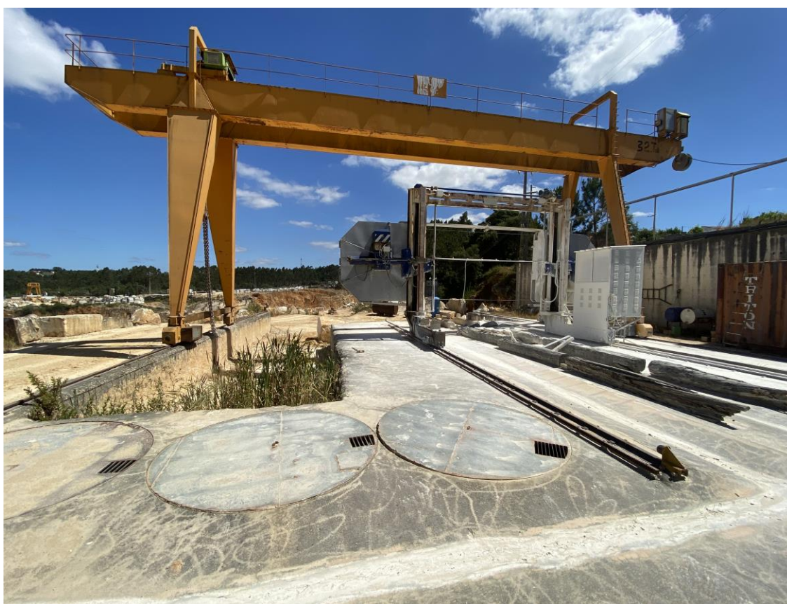
Foto 1 – Tanques de decantação de apoio ao aparelhamento de blocos no monofio por via húmida, indispensáveis à recirculação de água em circuito fechado.
