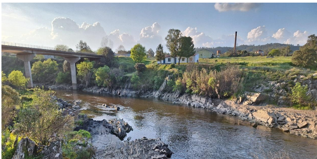
Figura 54 – Ponte nova sobre o rio Pônsul e vista da margem direita
