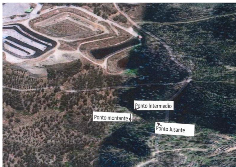
Figura 36 - Localização dos Pontos de Amostragem da Qualidade das águas Superficiais
