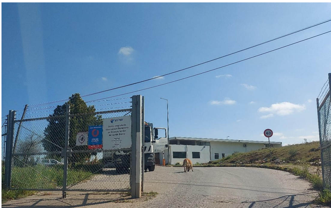
Figura 68 - Entrada das instalações da Valnor
