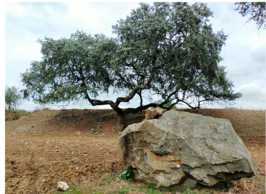
Talude exterior da lagoa. Ausência de fugas.
