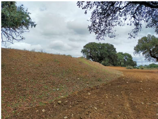
Talude exterior da lagoa. Ausência de fugas
