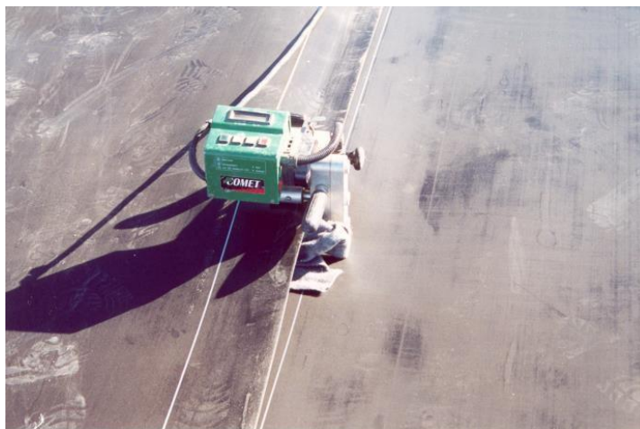
Soldadura por dupla pista
