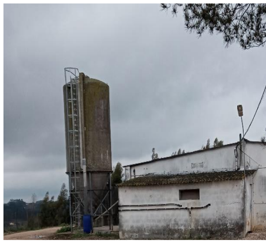
Figura 6.2 – Silos de Ração
