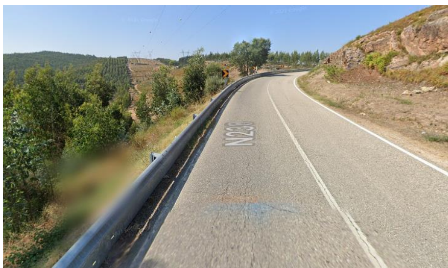
Figura 7.26 – Vistas da estrada nacional N238 que estabelece o acesso à instalação avícola.
