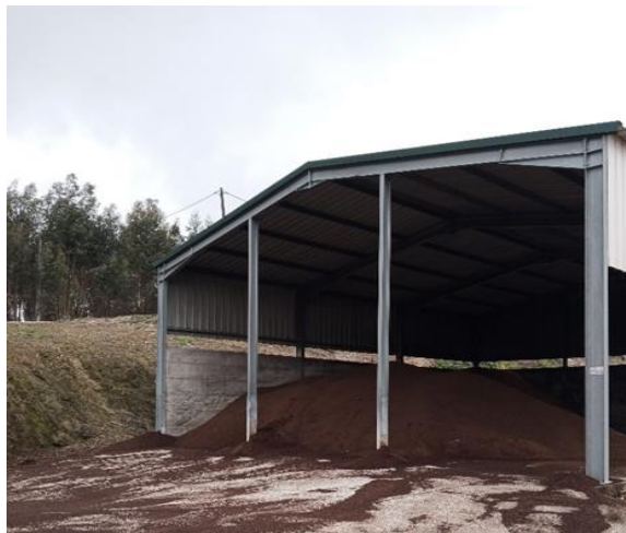
Figura 6.1 – Armazém de Biomassa
